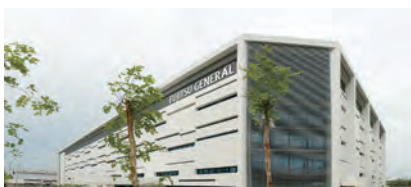
Centrum badawczo-rozwojowe w Fujitsu General Engineering (Tajlandia)
