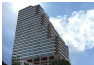
Fujitsu General (Tajlandia) Co., Ltd. Bangkok Office (Tajlandia)
